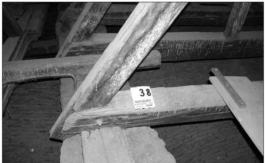
■ 7. kép: Lapolt szarufa–kötőgerenda kapcsolatok a négyezet feletti tetőszerkezetben, 2012
