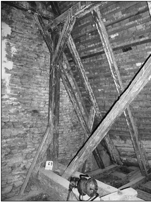
■ 20. kép: A déli mellékhajó feletti E tetőszerkezet nézete ■ Photo 20. View of roof structure E above the southern aisle
