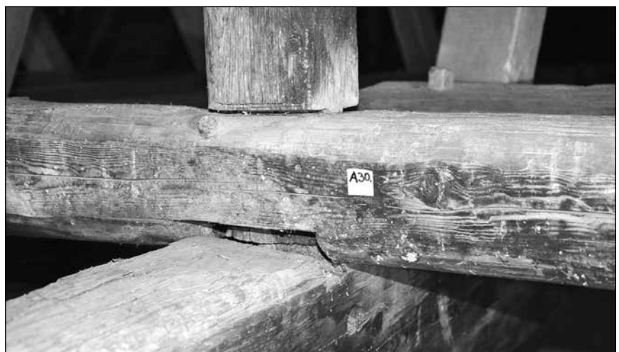
■ 8. kép: A székoszlop kapcsolata a talp- és kötőgerendával a négyezet feletti szerkezetben
