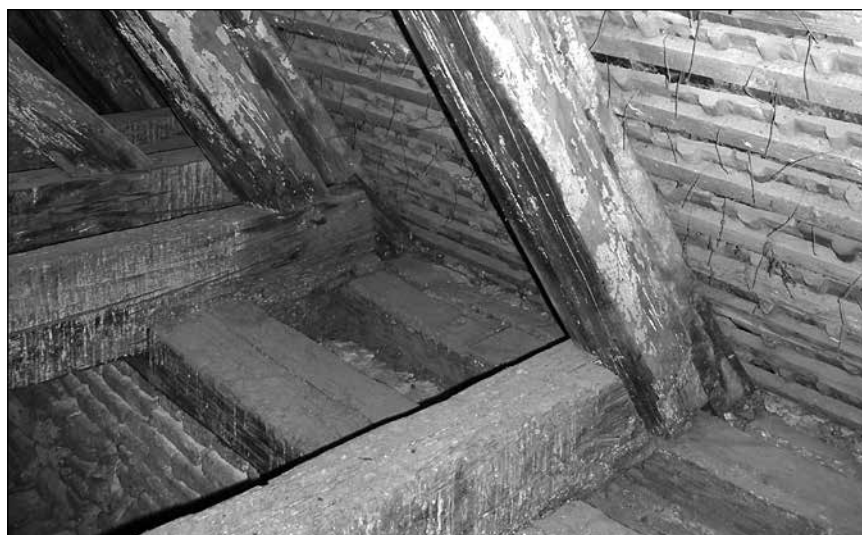
■ 16. kép: Lapolt és csapolt szarufa–kötőgerenda kapcsolat a főhajó feletti szerkezetben, egymás melletti állásokban
