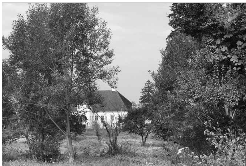
■ Foto. 5. Fațada estică a castelului Béldy Pál, privit din drumul principal al așezării © Andreea MILEA, 2009
