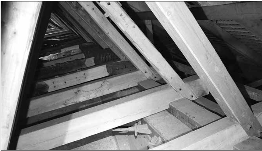
■ 23. kép: Szarufa–kötőgerenda kapcsolatok a szentély feletti tetőszerkezetben a felújítás után, 2016 ■ Photo 23. Common rafter and tie-beam joints in the roof structure above the choir after the renovation, 2016
