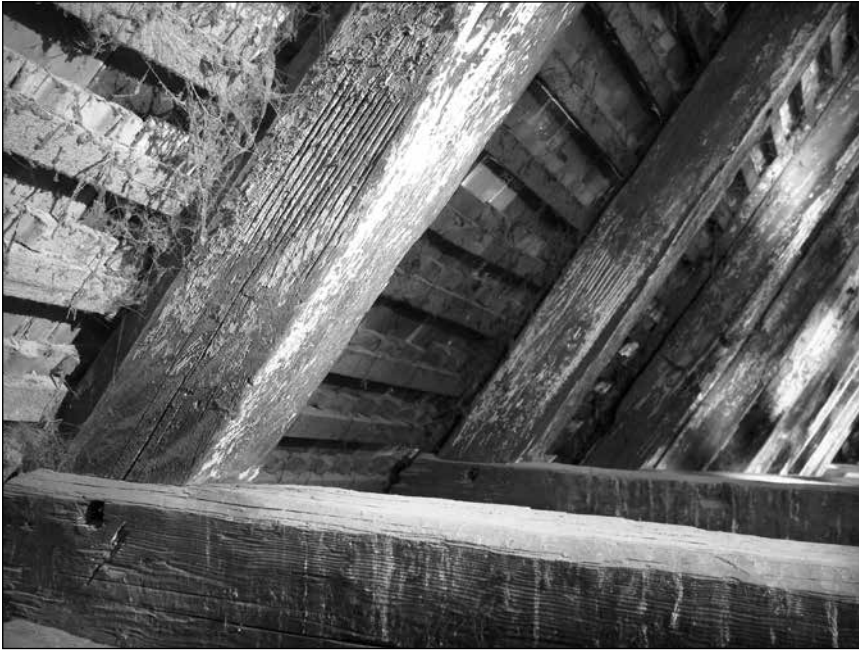
■ 5. kép: A szentély feletti tetőszerkezet déli szarufái. Állásjelek a 12. és 11. állásban. Csapolt szarufákötőgerenda kapcsolatok, 2012 ■ Photo 5. The southern common rafters of the roof structure above the choir. Truss markings in the 12 th and 11 th trusses. Mortice and tenon joint at the common rafter and tie-beam connection, 2012
