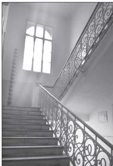
■ Foto 9. Balustradă originală din fier forjat ■ Photo 9. Original wrought iron railing
