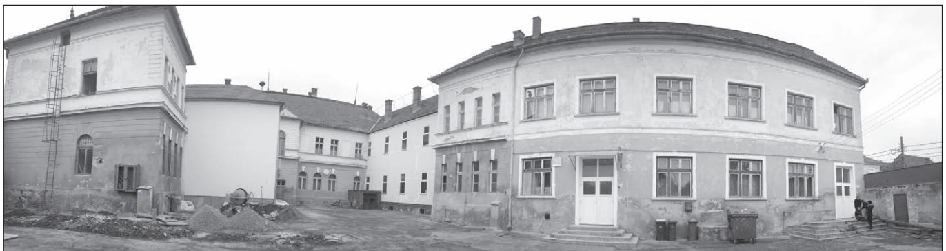
■ Foto 7. Fațada posterioară. Deranjantă, se vede în stânga casa scării (cadre b.a.) adăugată aripii drepte, spre curte ■ Photo 7. Rear elevation. Obtrusive, the staircase (reinforced concrete frames) added to the right wing, towards the courtyard, can be seen to the left
