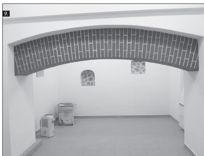
■ Foto 8. Elemente ale șarpantei afectate de incendiul cauzat de coșurile de fum ■ Photo 8. Roof structure elements affected by the fire caused by the chimneys ■ Foto 9. Subsolul corpului sud în fază terminală ■ Photo 9. Final stage in the basement of the southern block
