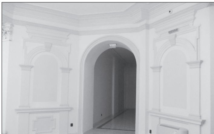
■ Foto 12. Ornamente din holul central după intervenție ■ Photo 12. Ornaments in the central hallway after intervention
