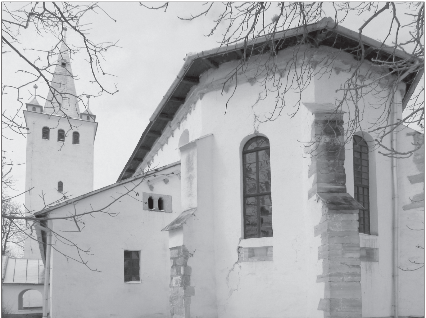
■ Foto 3. Fațada de nord-est înainte de restaurarea din 2013-2015 © Boróka SÁNDOR
