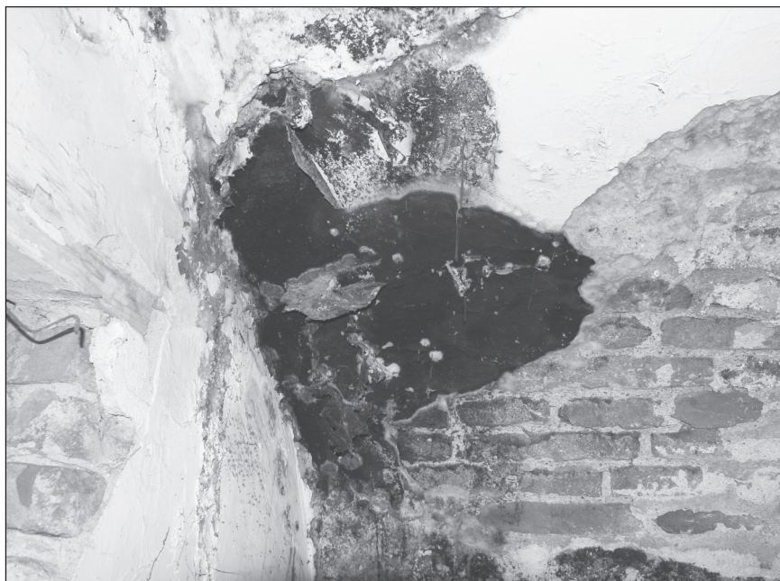
■ Foto 2. Corpuri sporifere îmbătrânite ale buretelui de casă © Octavian COROIU ■ Photo 2. Old fructification bodies of Serpula lacrymans © Octavian COROIU
