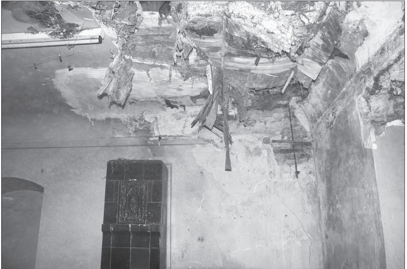
■ Foto 7. Planșeu degradat © Octavian COROIU
