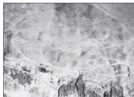
■ Foto 3. Dezvoltarea miceliului în condiții favorabile (subsolul Conacului Gallus din Gilău, 2015) © Octavian COROIU
