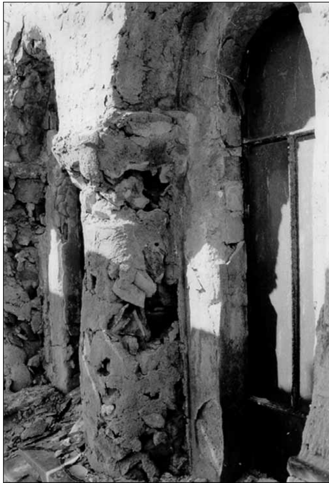
■ 8. kép: Homlokzatrekonstrukció ■ Photo 8. Reconstruction of an elevation
