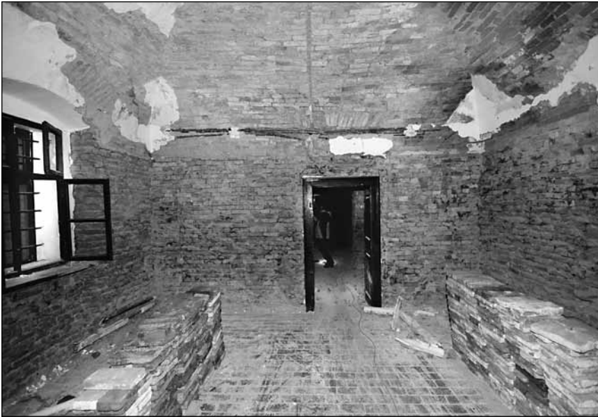
■ 1. kép: Hortobágyi csárda, aminek a vakolatát kutatás nélkül elkezdték levetni ■ Photo 1. A tavern in Hortobágy, where the plaster was removed without making any researches on it
