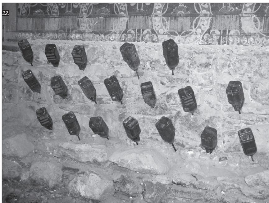
■ 21. kép: Lyukfúrás mélyvédelemhez © BÁNKY László, KIRÁLY Béla ■ 22. kép: Mélyvédelem (illusztráció) © BÁNKY László, KIRÁLY Béla ■ 23. kép: Poroszsüveg földém átáztatása védőszerrel © BÁNKY László, KIRÁLY Béla
