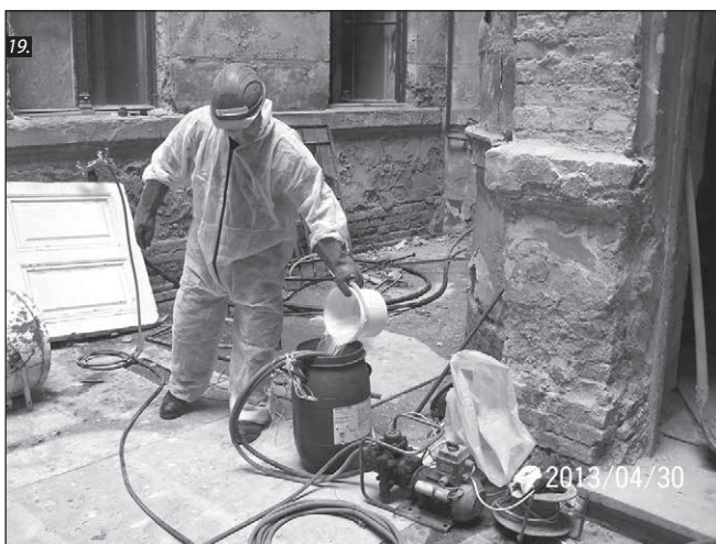
■ 17. kép: Gombafonal követése, téglafugák kivésése © BÁNKY László, KIRÁLY Béla ■ 18. kép: Falazat hőkezelése © BÁNKY László, KIRÁLY Béla ■ 19. kép: Falazat permetezésének előkészítése © BÁNKY László, KIRÁLY Béla ■ 20. kép: Falazat permetezése © BÁNKY László, KIRÁLY Béla ■ Photo 17. Follow-up of a fungus line, carving out the interstices between bricks © BÁNKY László, KIRÁLY Béla ■ Photo 18. Heat treatment of masonry © BÁNKY László, KIRÁLY Béla ■ Photo 19. Preparing the spraying of the masonry © BÁNKY László, KIRÁLY Béla ■ Photo 20 Spraying of the masonry © BÁNKY László, KIRÁLY Béla
