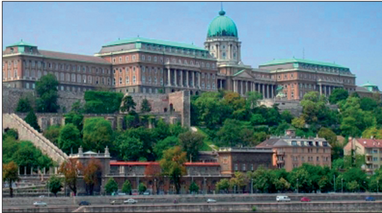
■ 2. kép: A testőrségi palotától a vízfordó lépcsőig ■ Photo 2. From the Guards' Palace to the stairway for water carrying
