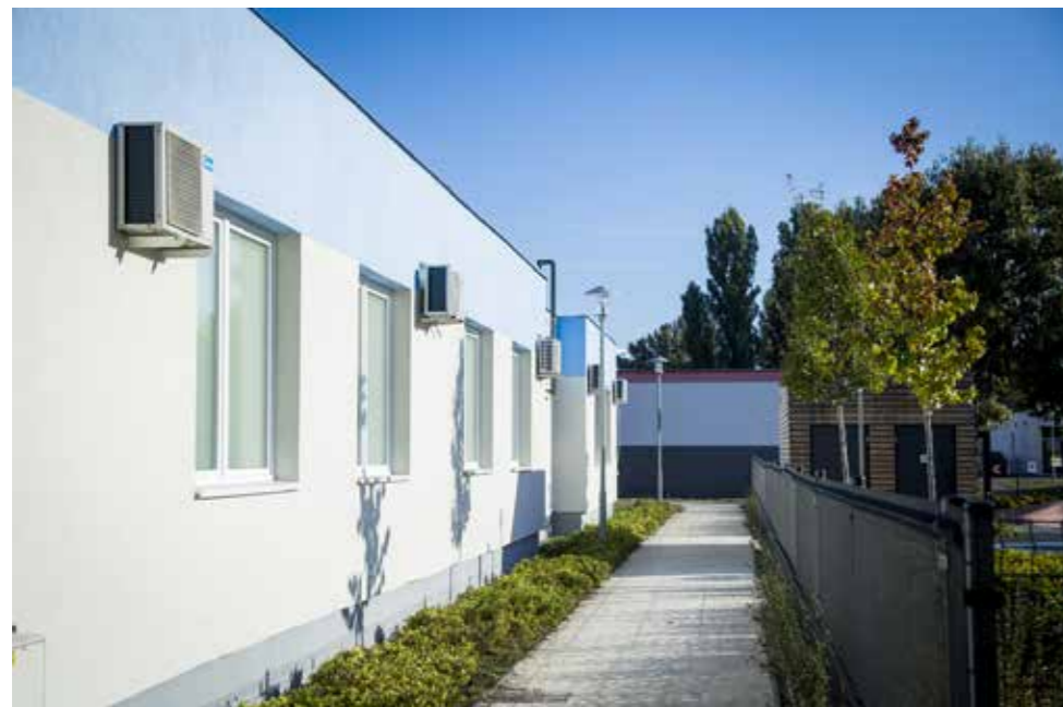
Befejeződött a felújítás első üteme
