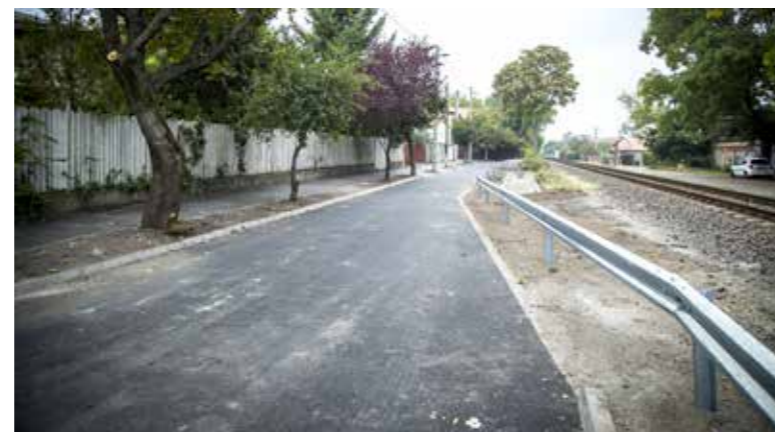
Háromszáz méteres szakaszt aszfaltoztak le
