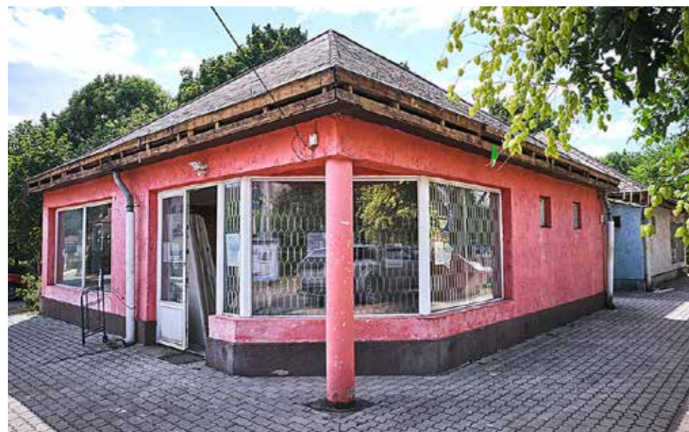
Teljesen megújul a Temesvár utcai épület
