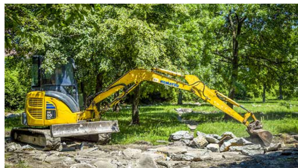
Jelenleg a bontási munkálatok zajlanak
