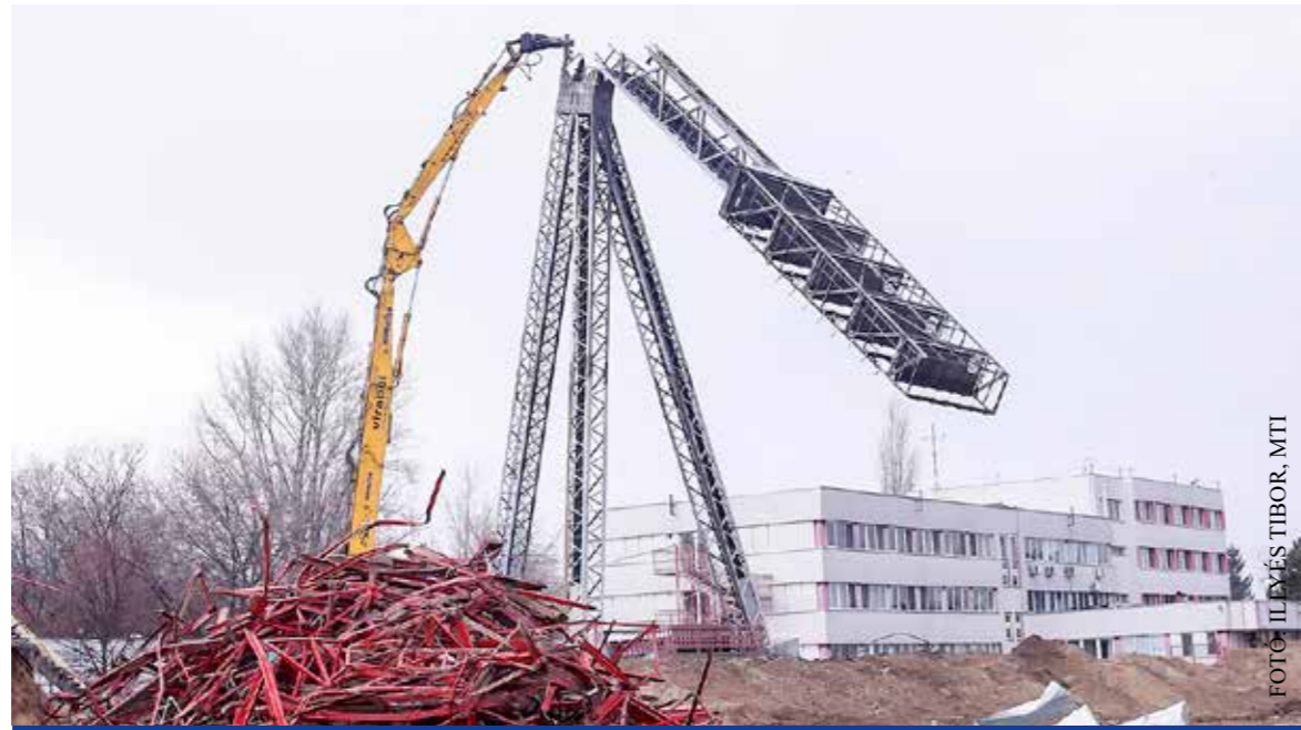
Az utolsó lámpatartó oszlop elvágása
