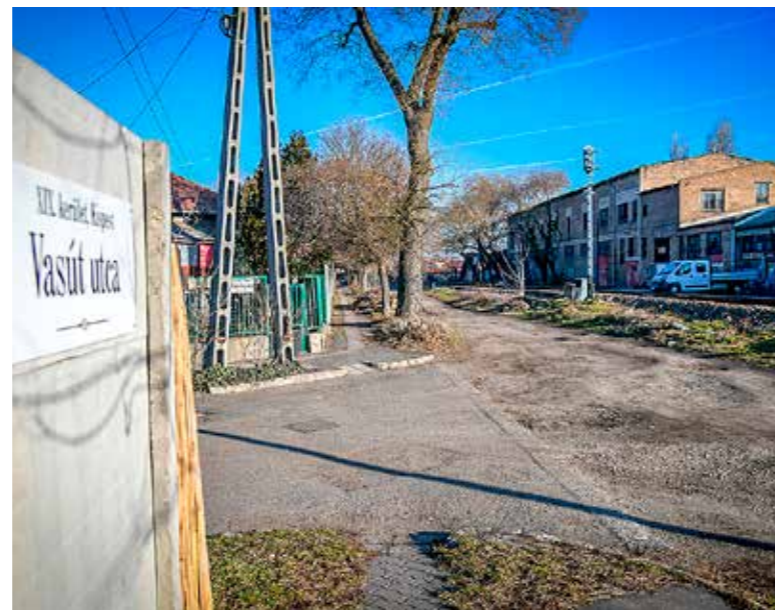
Szilárd burkolatot kap a Vasút utca
