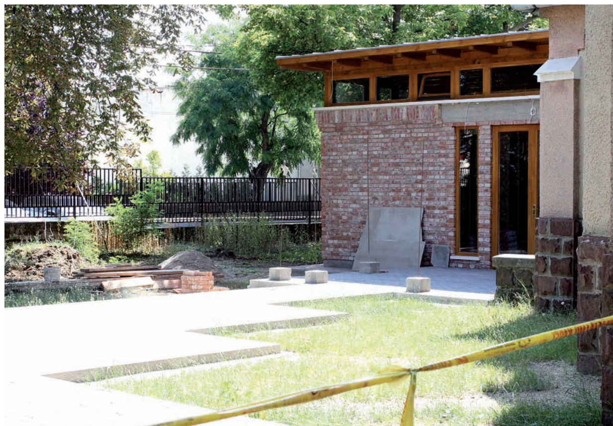
A szentimrei urnatemető építése lassan befejeződik
