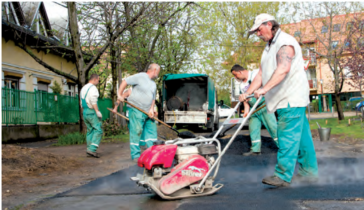
A kátyúzások befejezését követően indulhat a járdák javítása
