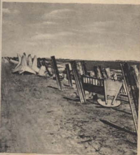
Az akadályok közé bölcsőt is tettek.
