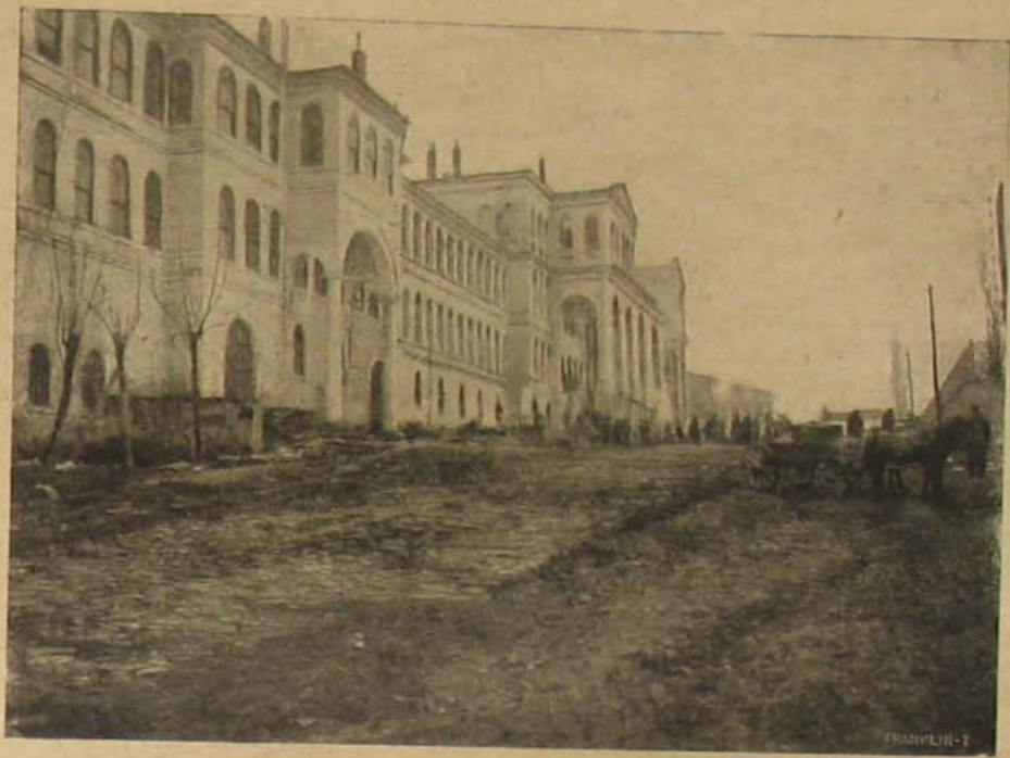
A «magas porta» oldalezárnya a tűzvész után.
