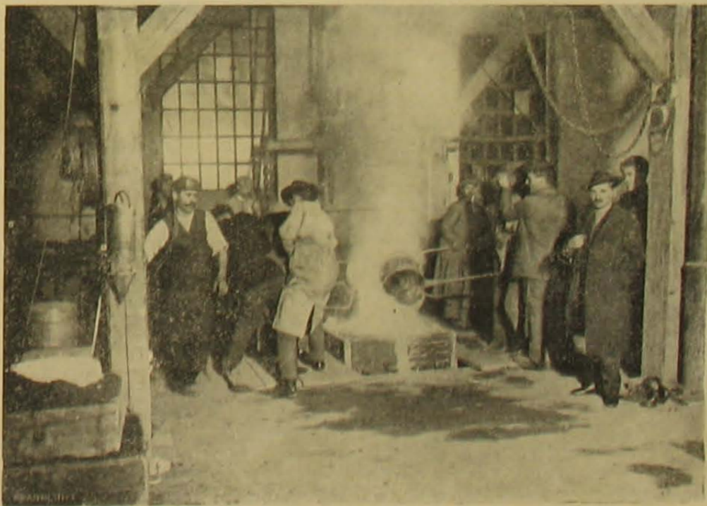
A bronz beöntése a súlyasztó gödörben levő formába.
