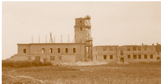
Az épülő templom és lakóházak
