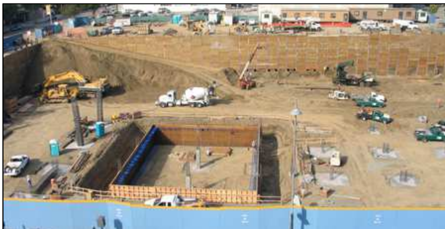
16. ábra ... és annak építése (Forrás: https://smpl.org/Sustainability/Water_Management.aspx )
