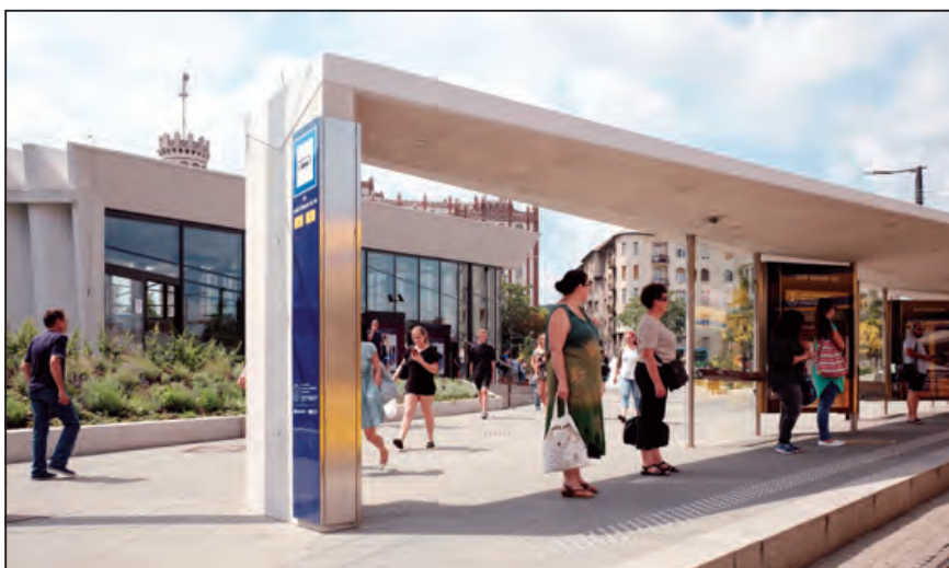
A legyező betonépülete határozta meg az új épített elemek megjelenését
