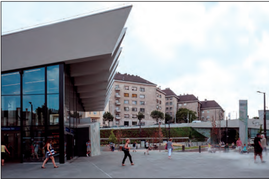
Növényekkel és padokkal tagolt, párasított belső gyalogos zóna a Széll Kálmán téren
