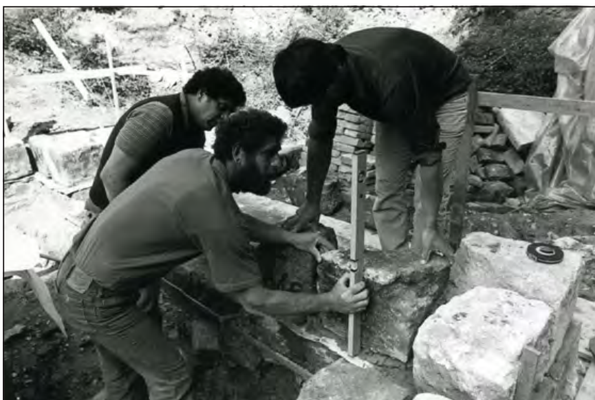
A régi kövek visszahelyezésével kezdődött az újjáépítés
