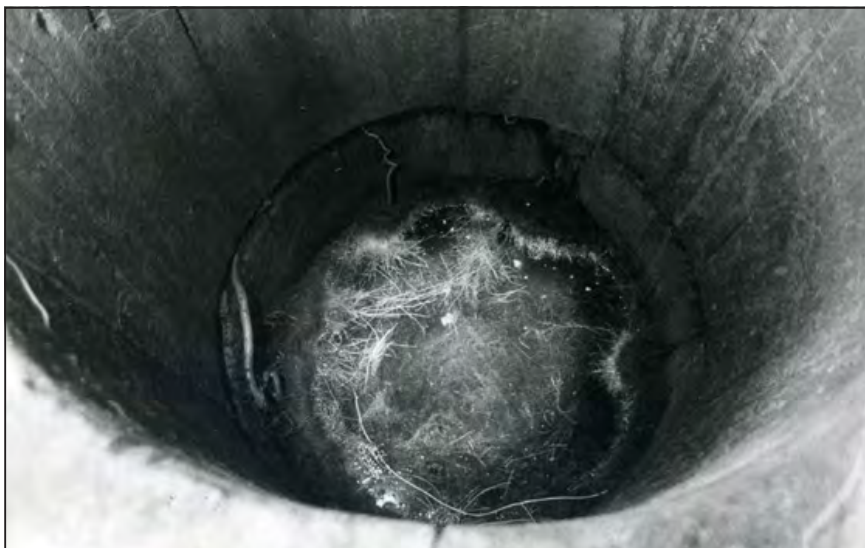
A forrásfoglalás érintetlennek bizonyult – csak a gyökerek nőttek be a víztükröt
