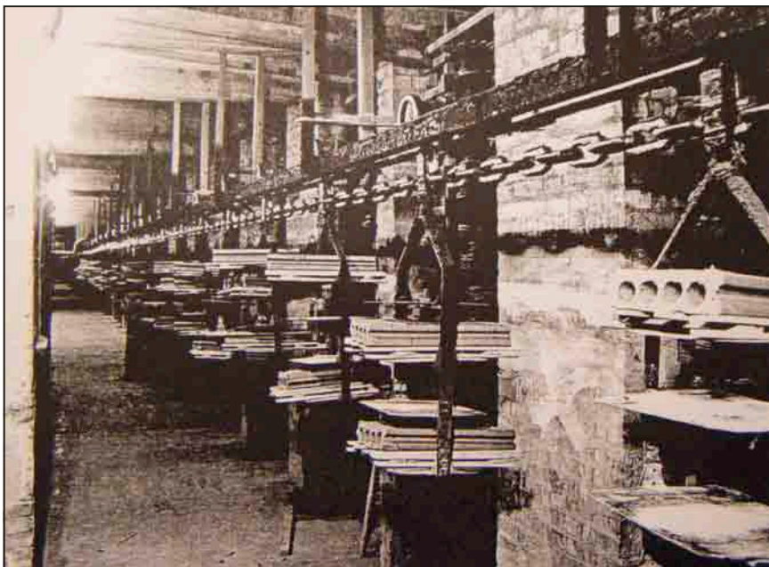
Lánvcvontatású, függesztett szállítósor viszi a kiperéselt „négylyukú” válaszfaltéglákat a szárítóba
