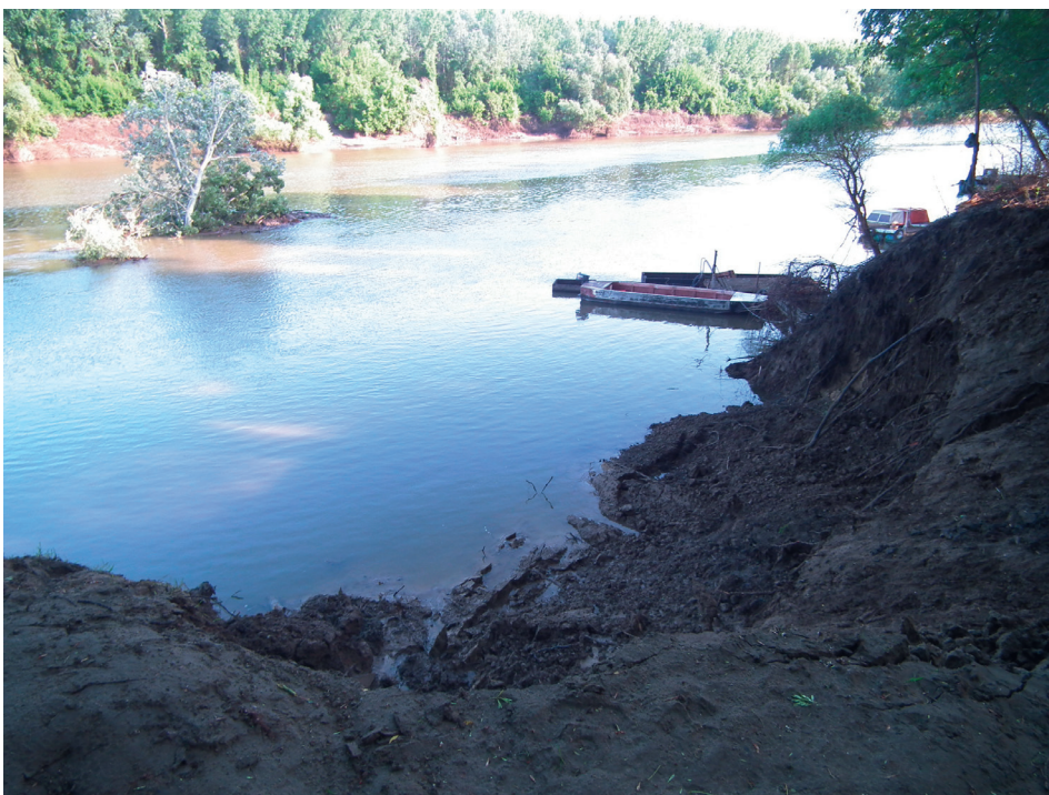
1. kép Karéjos csuszamlás a mindszenti Nagyrév É- i részén (Fotó: KIS MOLNÁR I.) Picture 1 Arcuate landslide N of the Mindszent Nagyrév (Photo by KIS MOLNÁR, I.)
