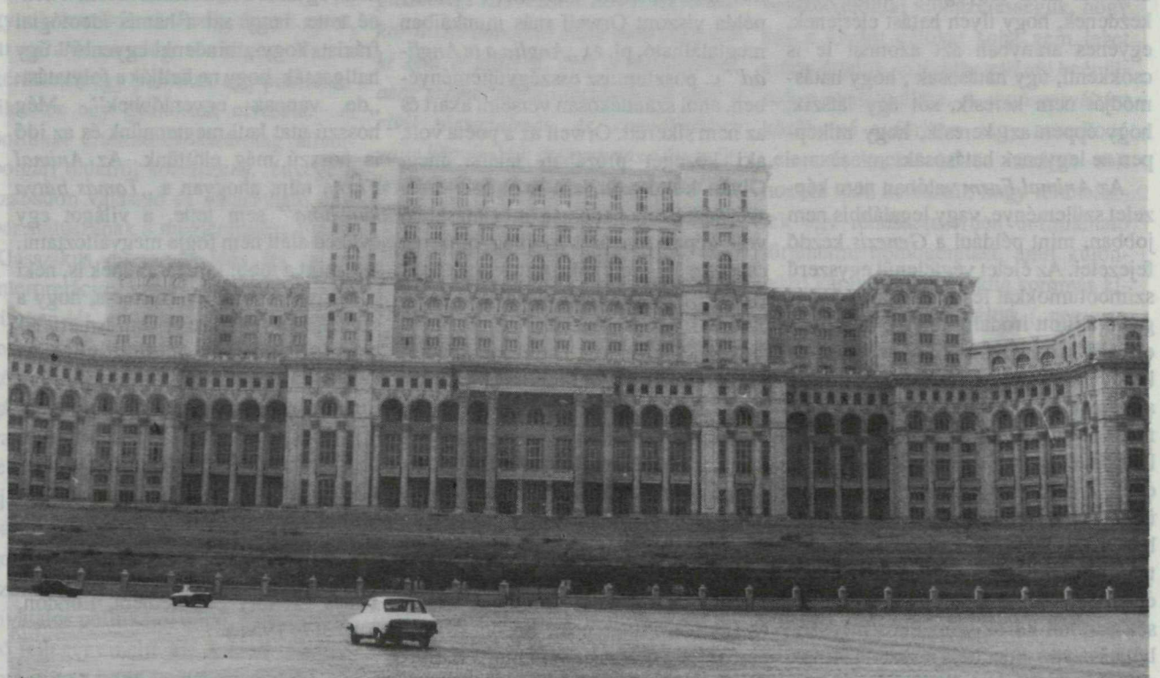
A Ceausescu-palota közelről. Állítólag folytatják az építkezést. Fotó: Fazekas Sándor
