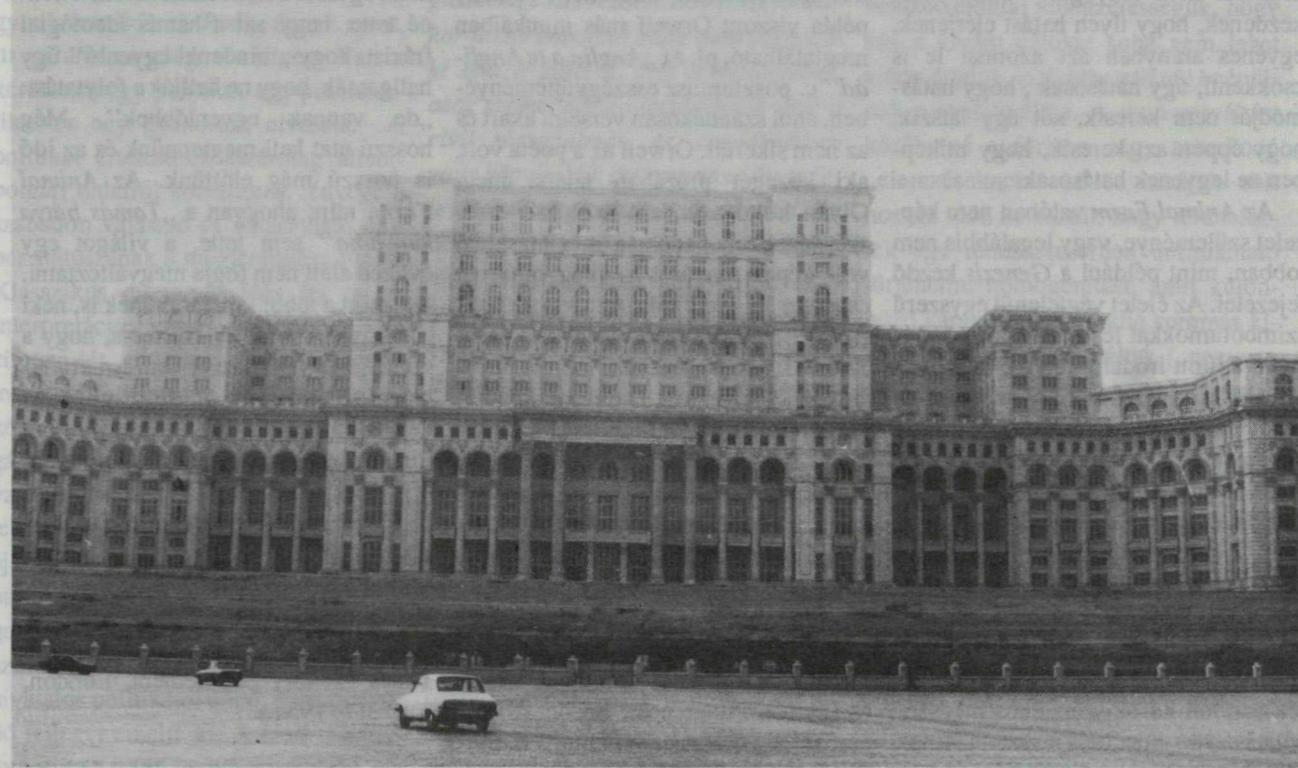
A Ceausescu-palota közelről. Állítólag folytatják az építkezést. Fotó: Fazekas Sándor
