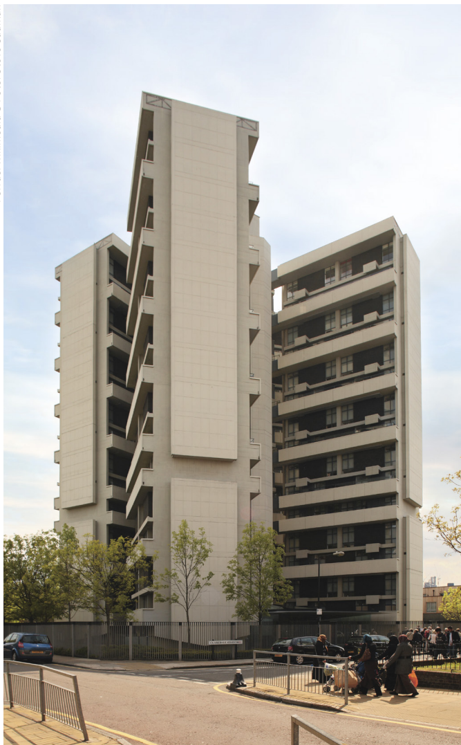
Keeling House toronyház, Bethnal Green, London [Denys Lasdun, 1954–57]
