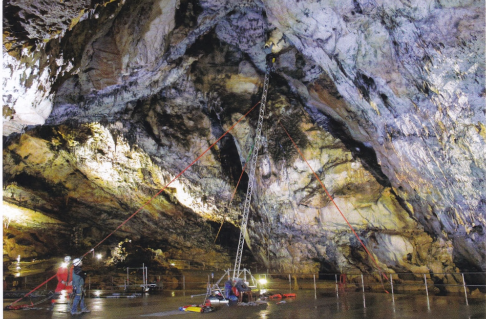
A Táncstermi-kürtő „támasztása”, és az indítóstand kiépítése (Fotó: Szabó Zoltán)
