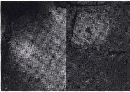
10. kép. Baradla-barlang Tigris-terem - Styx lejárát, észlelő kút. Mivel az észlelő kút egy ma is használt járda közepén került kialakításra, a csőperem kiképzése egy vasbeton lemez segítségével történt. A hulladék észlelő kútba hullásának megakadályozását egy gumi lemez és egy azt a vasbetonlemezhez leszorító saválló, acél bordás lemez biztosítja. A kút speciális számmal nyitható, ezáltal olyan kútkialakítást sikerült megvalósítanunk, amely nem akadályozza a közlekedést, azonban a tudományos vizsgálatokhoz időtállóan biztosítja a kútat.
