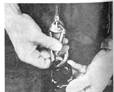
9. és 10. ábra. A lapkás ereszkedő rákapcsolása beülőre
