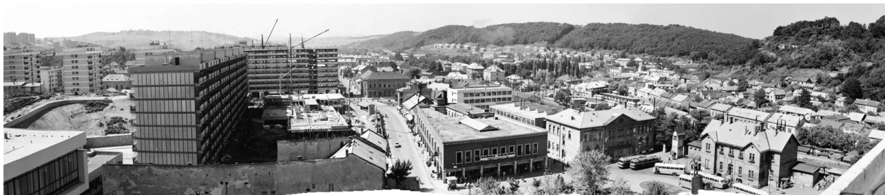
Az épülő Salgótarján az 1960-as években
