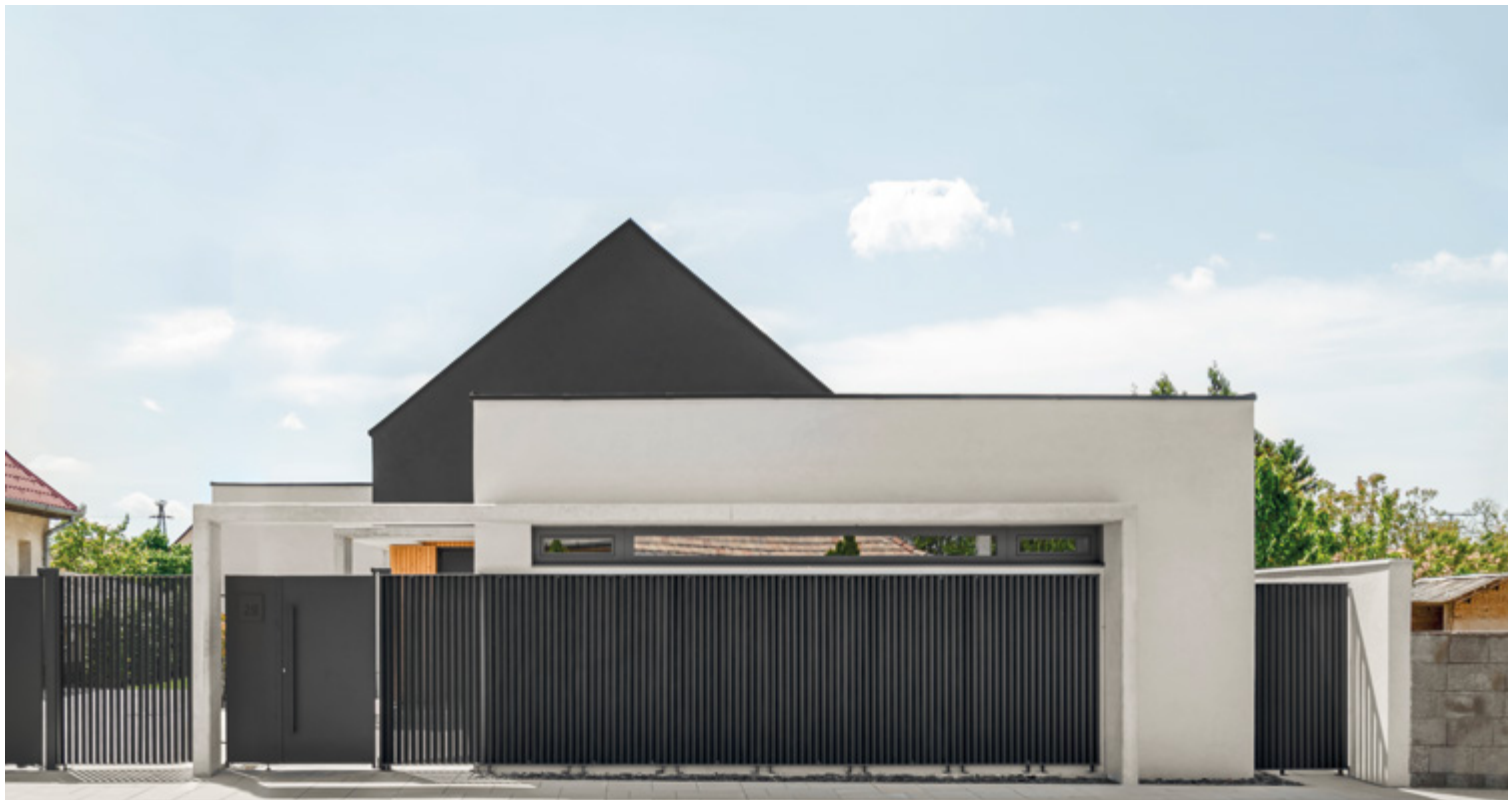
Az utcavonalra húzott garázs tömege az egységesen megkomponált kerítésfal részévé válik
