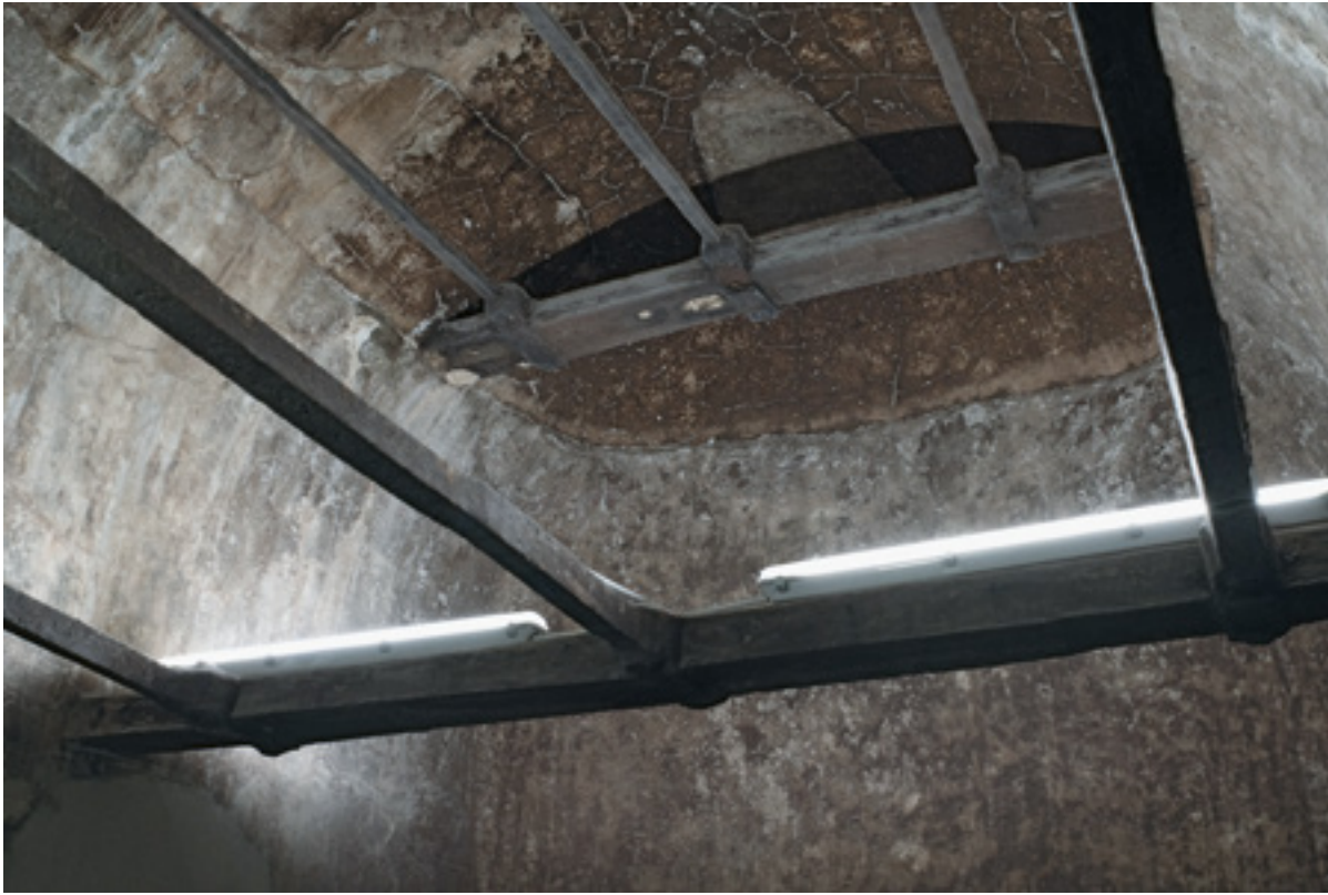
A bor- és olajtankok helyén kialakított mellékhelyiségekben a világítást az oldalirányú folyadéknomás felvételére szolgáló vonóvasakhoz rögzítették
