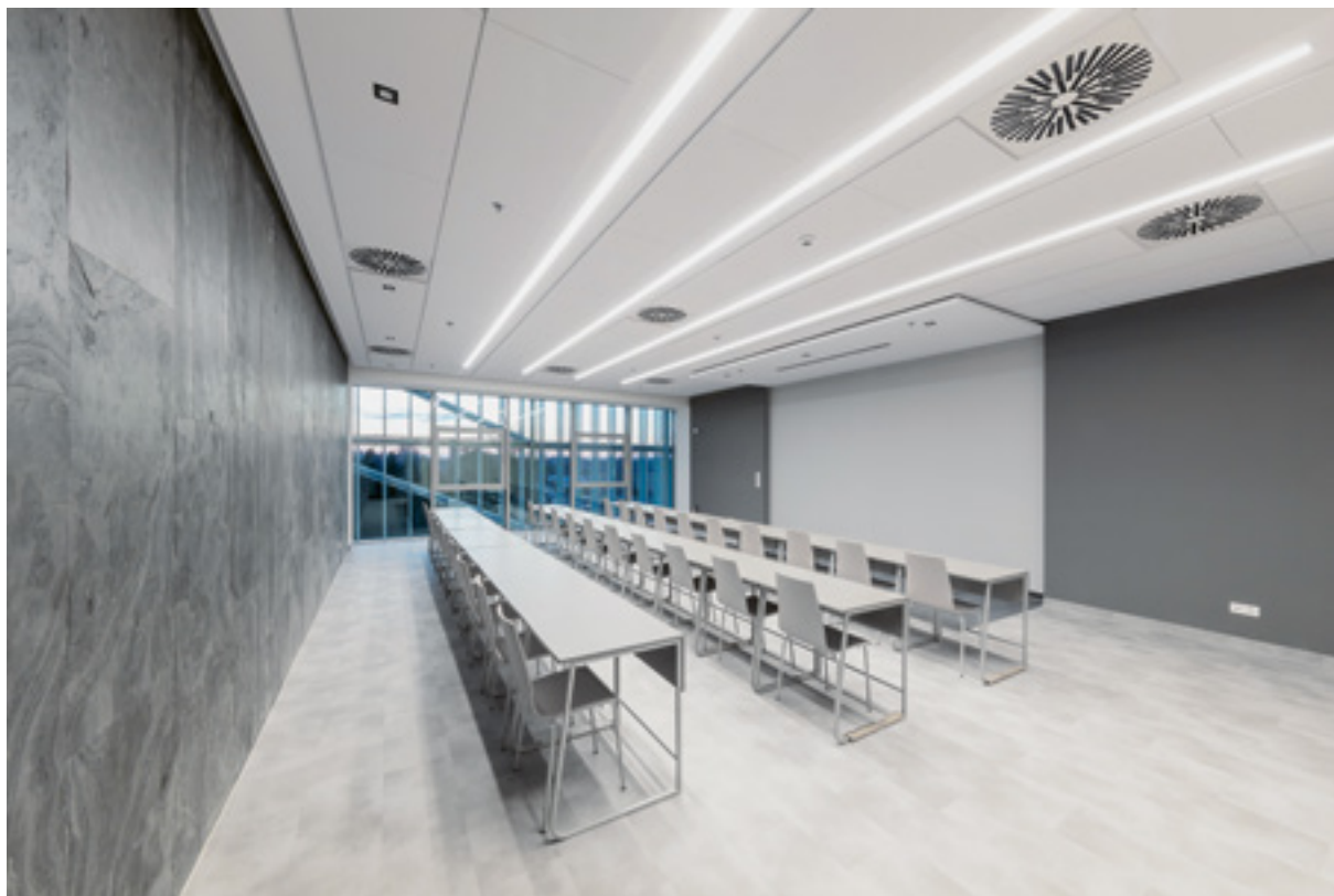
A szemináriumi termek végfalai szürkés, palakő hatású burkolatot kaptak
