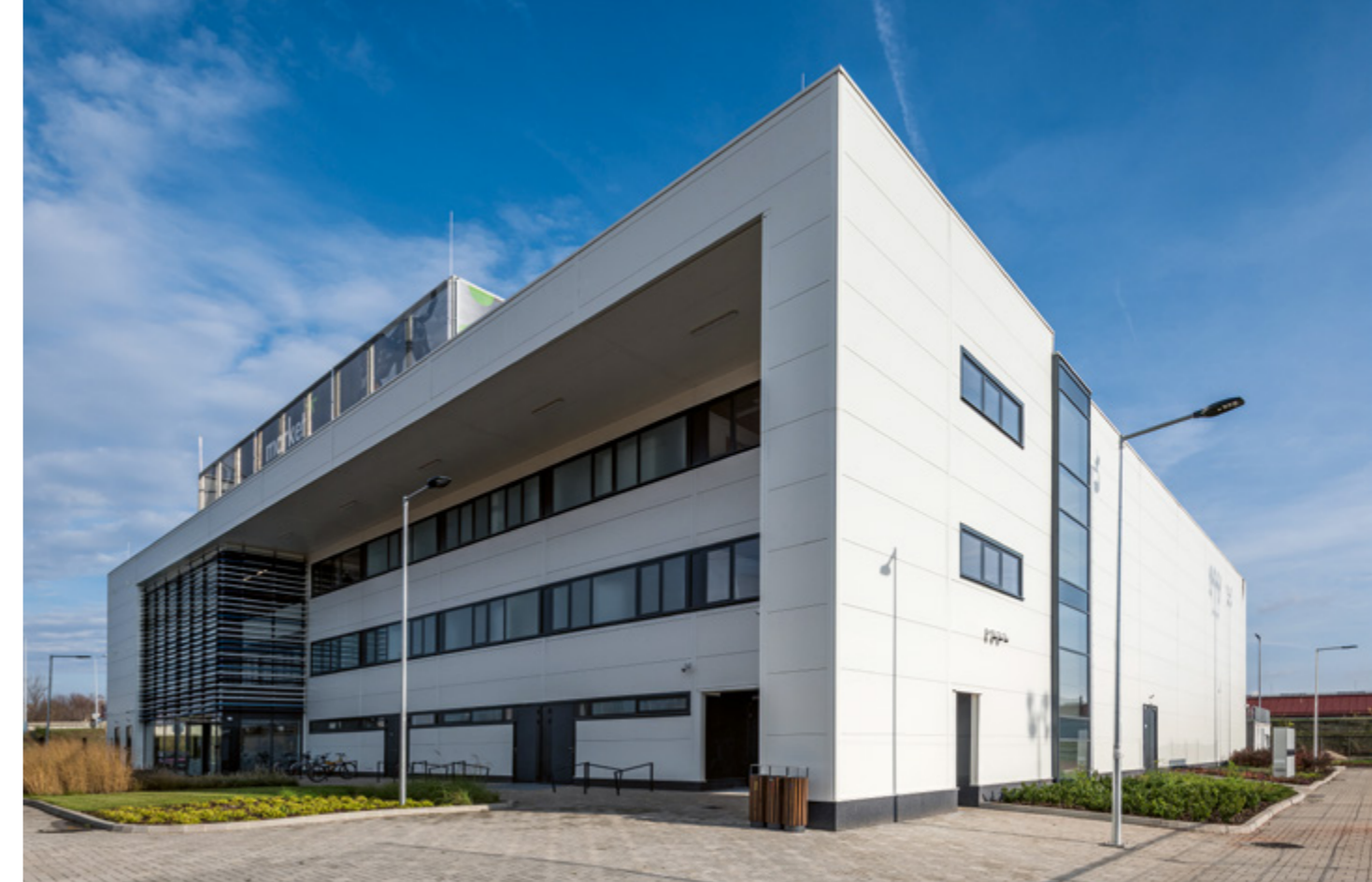
A rendezvénycsarnok többek közt az esővíz újrahasznosításának képességével LEED Gold minősítést nyert el
