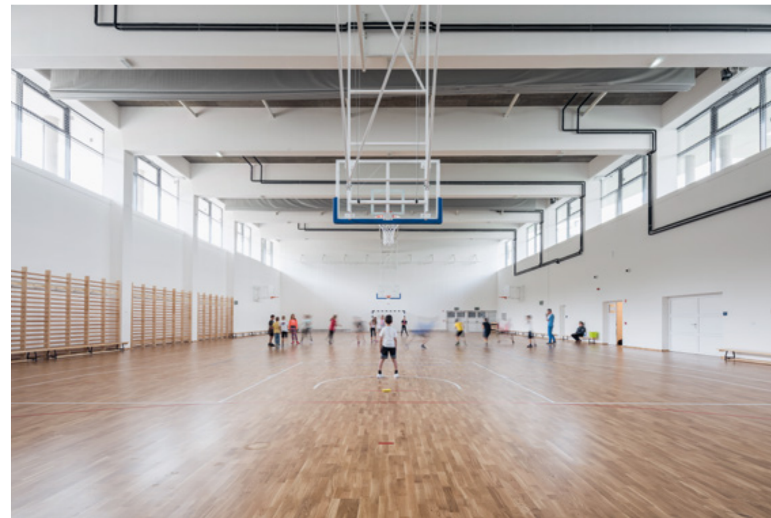
^ A tornaterem félig a földbe süllyesztve, az öttört vasbeton lemez alatt kapott helyet
