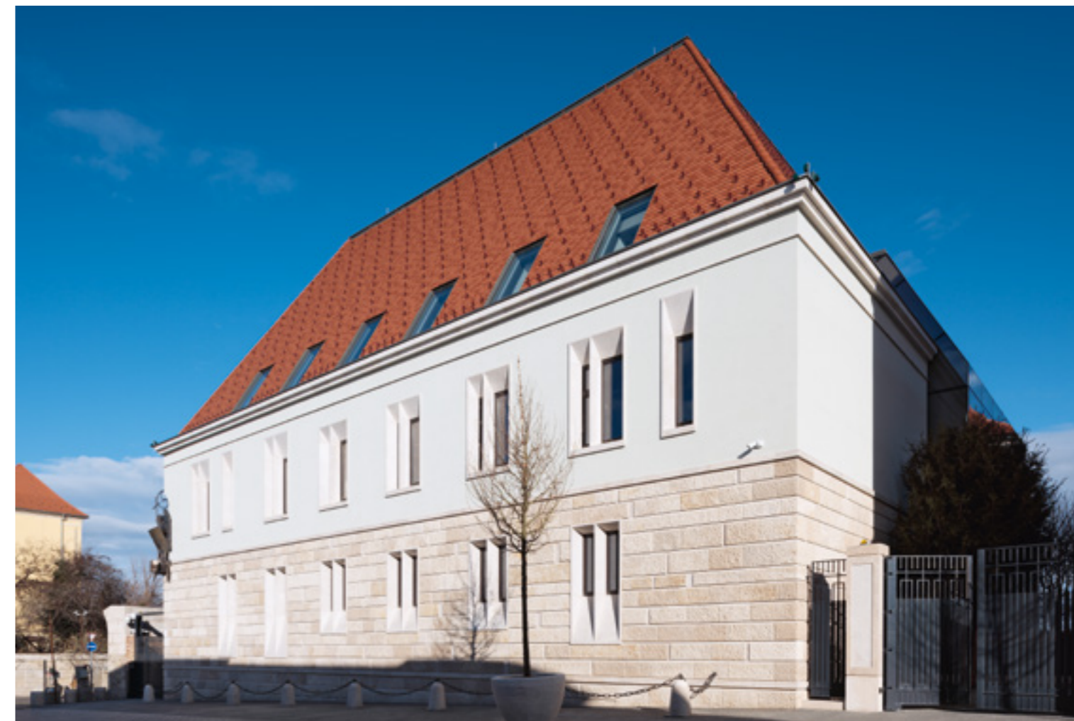
Az új épület kváderezése valódi kőtömbökből, hagyományos falazással készült, az ablakbéléteket egy-egy tömbből faragták ki. (Fotó: RPT)
