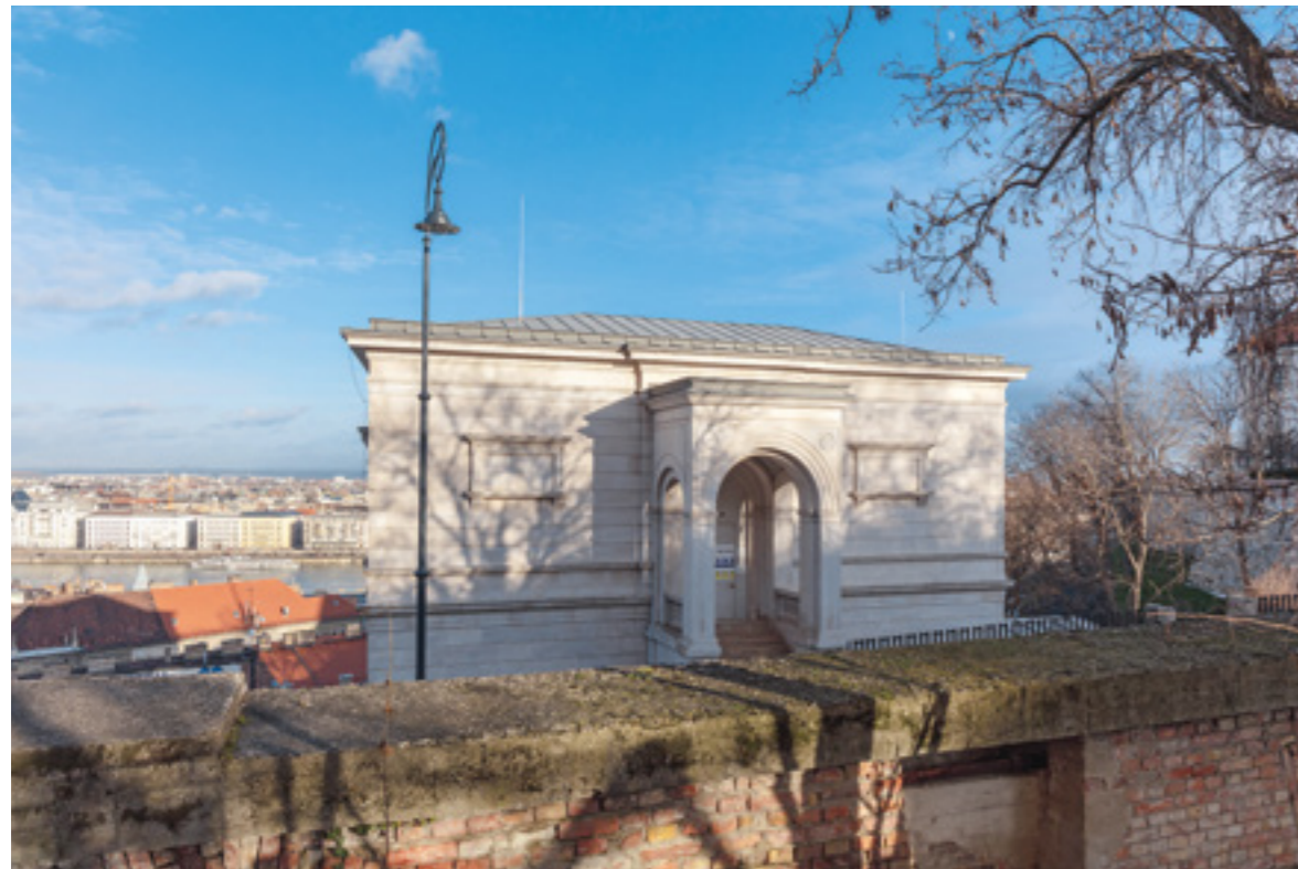
< A kiváló műgyűjtő, Hatvany Ferenc II. világháborúban elpusztult budai villájának újjáépítése 2000-ben indult, és hosszas leállás után nemrég a Magyar Nemzeti Bank beruházásában folytatódott. (Fotó: Bujnovszky Tamás)
