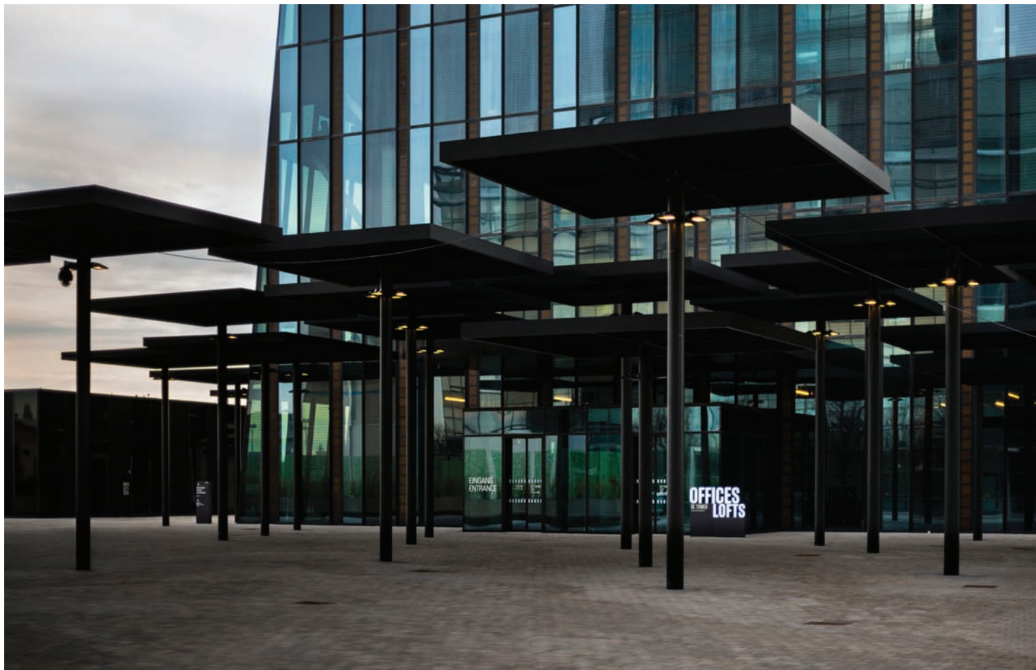
Egyedi árnyékolórendszer került az épület köré (a tálcák szarai egyben kandelláberek), és Perrault elmondása szerint részben azt a célt szolgálják, hogy emberi léptékűvé tegyék a megérkezést, kompenzálva a ház monumentalitását
