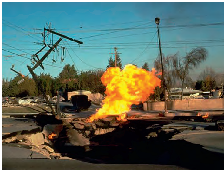
1. ábra. Az 1994-es Northridge (Kalifornia) földrengés ( M=6,7 ) következtében egy elszakadt vezetékéből áramló gáz is lángra lobbant (Forrás: USGS)
