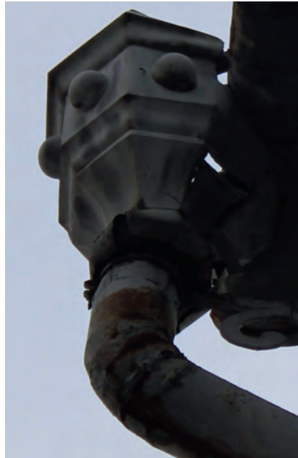
3. ábra. Siralmas állapotban levő vízgyűjtő üst a hajdani Honvéd utcában
