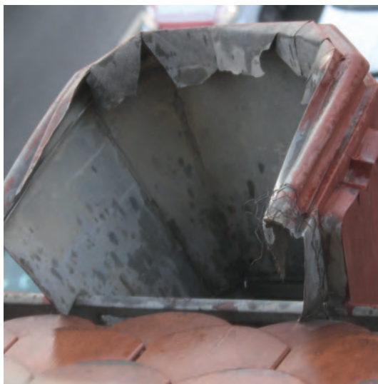
11. ábra. Vízugyjtő üst belülről
