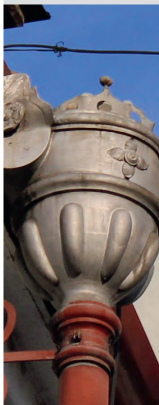
6. ábra. Síralmas állapotban levő vízgyűjtő üst a hajdani Honvéd utcában
