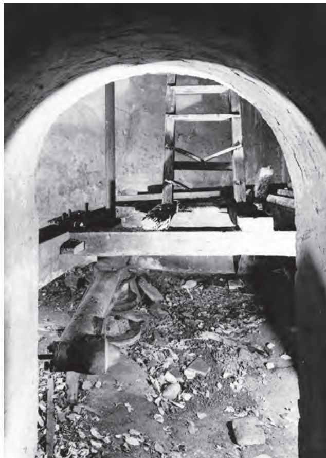
6. ábra. A Barker-turbina kerékgödre 1851 körül Hacienda Buena Vistán
