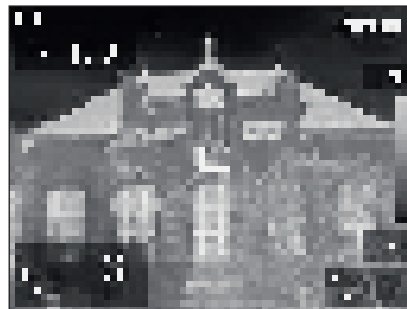
6. ábra. Az iskola homlokzata infrakamerával készített felvételen
