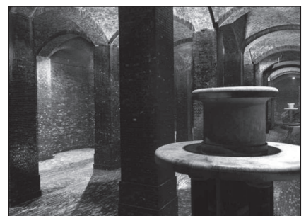
A kőbányai víztározó
