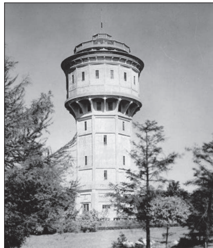
A kőbányai víztorny
