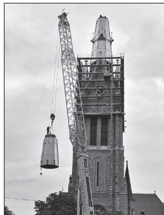
A torony feldaruzása (Makovics Kornél felvételei)
