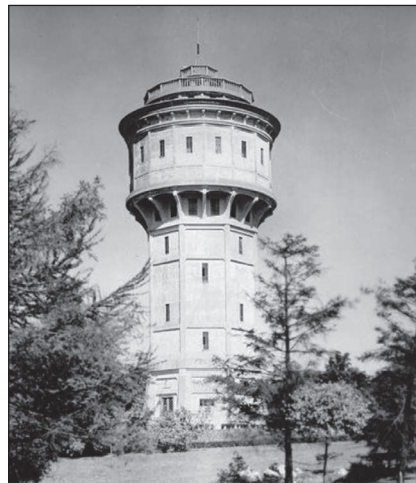
A kőbányai víztorny
