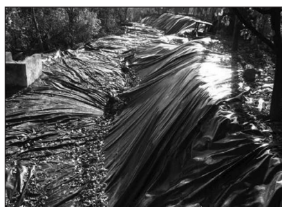
5. kép. Ivó utcával párhuzamos szakadás 1/2 (2010-11-05) (Forrás: Sycons Kft.)
