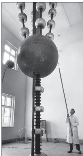
Az első Van de Graaff-féle „electrica machina” Debrecenben. Épült a Kísérleti Fizikai Tanszéken Koltay Ede irányításával. A fénykép az 1950-es évek második felében készíthető
