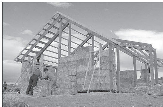
A szalmaház stabilitását faszerkezet biztosítja
