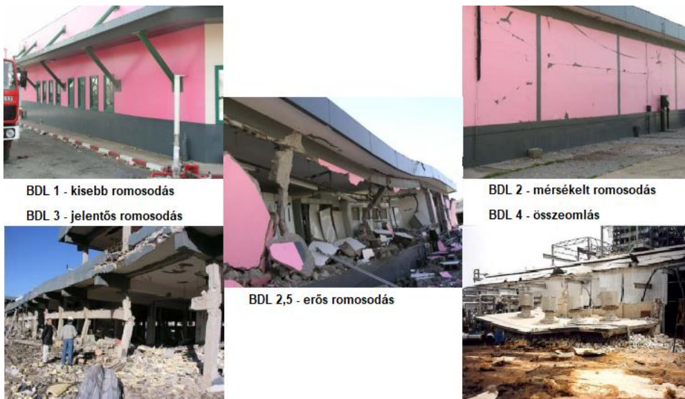
10. számú ábra. Épületromosodási szintek 48
