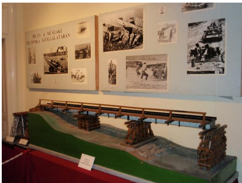
7. számú ábra. Vasúti viadukt provizórium
