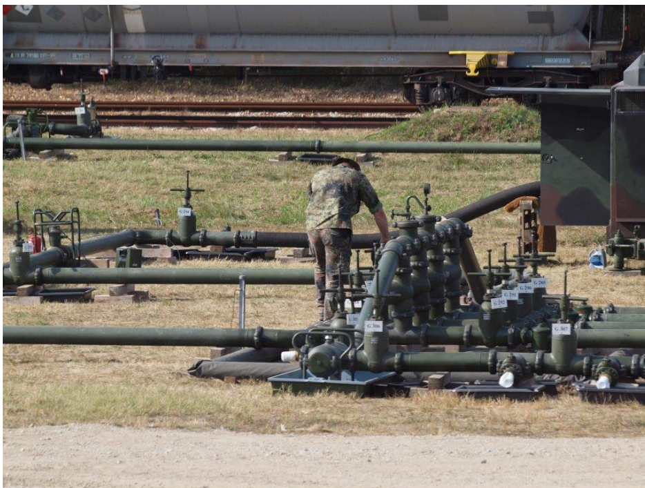
4. ábra. Az üzemanyag elosztására szolgáló csővezeték-csomópont
