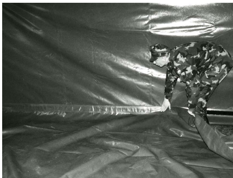
7. ábra – Aljzatfólia felcsatolása
